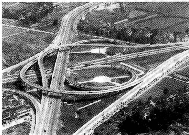
沪宁高速公路苏南段上的大型立交
